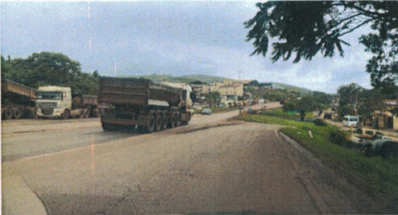
Foto 65 (Km 611): Estreitamento de pista para viaduto.
