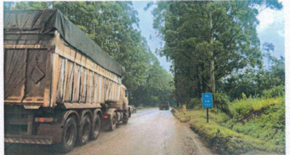
Foto 50 (Km 599): Falta de acostamento.
