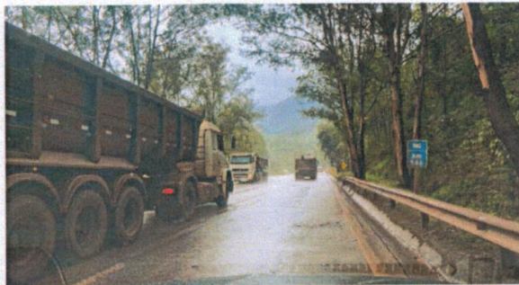
Foto 29 (Km 586): Falta de Acostamento.
