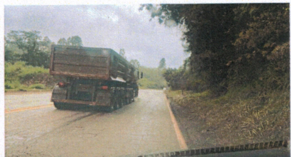
Foto 62 (Km 606): Falta de acostamento.
