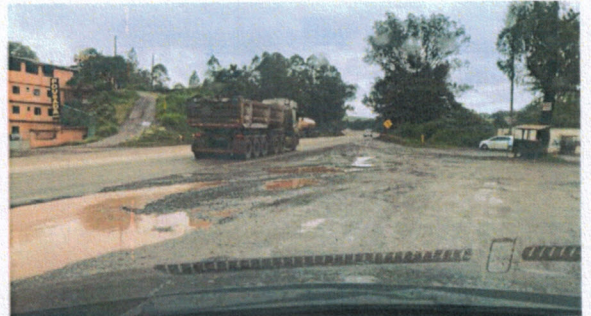
Foto 66 (Km 611): Acessos urbanos
