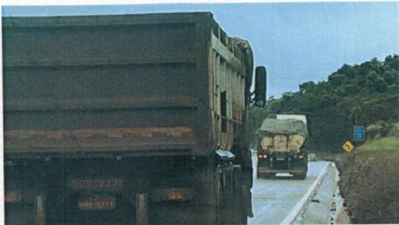
Foto 9 (Km 571): Falta de acostamento.
