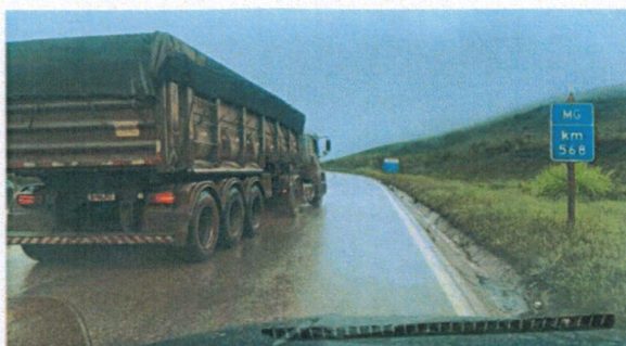
Foto 5 (Km 568): Ausência de acostamento.
