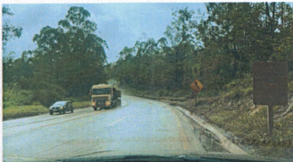
Foto 45 (Km 596): Sinalização ilegível.
