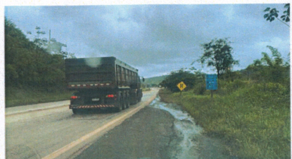
Foto 64 (Km 611): Estreitamento de pista para viaduto.
