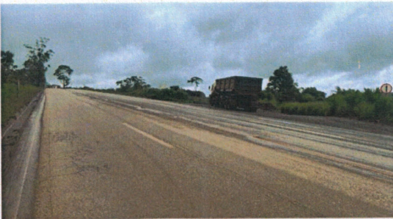
Foto 27 (Km 584): Acesso de mina.
