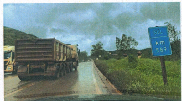
Foto 32 (Km 589): Falta de acostamento.
