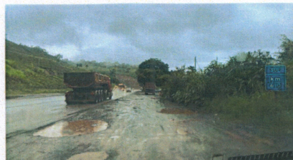
Foto 63 (Km 610): Acessos urbanos.
