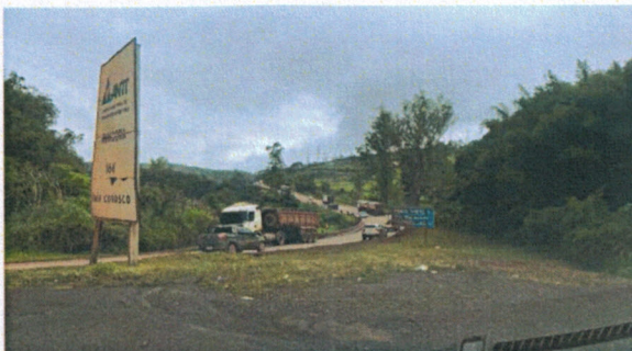
Foto 69 (Km 615): Estreitamento de pista ponte e viaduto.
