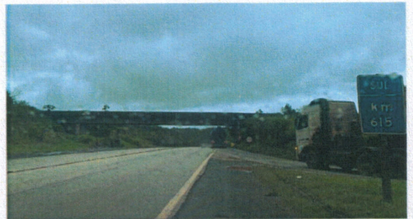
Foto 68 (Km 615): Estreitamento de pista para ponte e viaduto.
