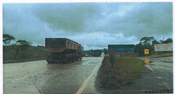
Foto 60 (Km 605): Sinalização ilegível.
