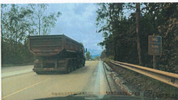
Foto 23 (Km 581): Canaleta obstruída.
