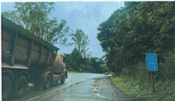
Foto 57 (Km 604): Falta de Acostamento.
