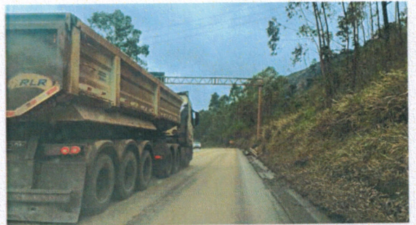
Foto 20 (Km 577): Canaleta obstruída.
